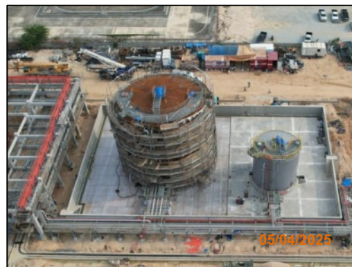
งานโครงสร้างถังเก็บสารเคมี
