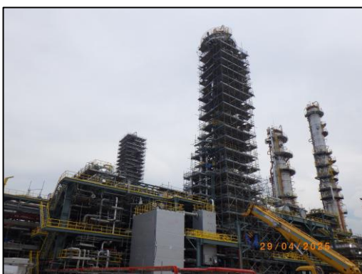
งานติดตั้งหอกลั่น (Gas Column Installation)
