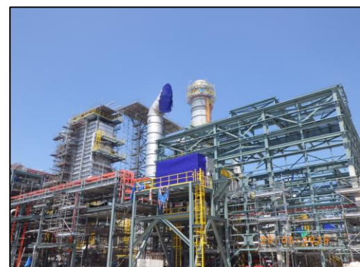
งานติดตั้งหน่วยหมุนเวียนพลังงานความร้อนเหลือทิ้งกลับคืน
