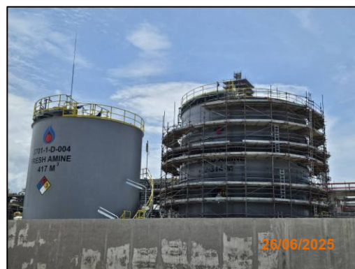
งานโครงสร้างถังกักเก็บสารเคมี
